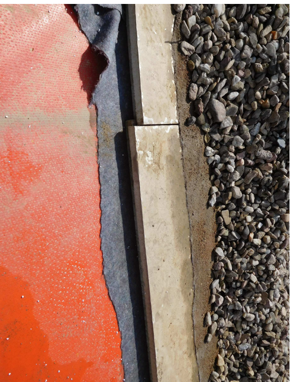
STÁVAJÚCI SKLADBA NAD HYDROIZOLAČNÍ FÓLII
